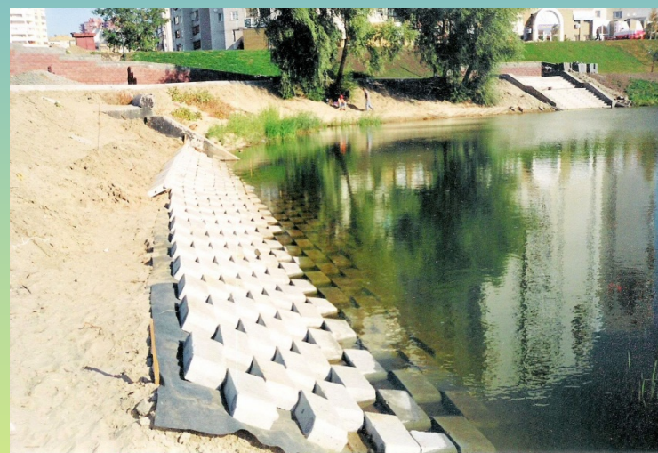
Захист укосів озера Позняки в м. Києві гнучкими кріпленнями з використанням нетканих геотекстильних матеріалів
