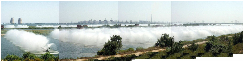
Панорамний знімок великомасштабної бризкальної системи охолодження Запорізької АЕС, створеної за участі відділу ТВМ (аеротермічний розрахунок, великовитратні сопла)
