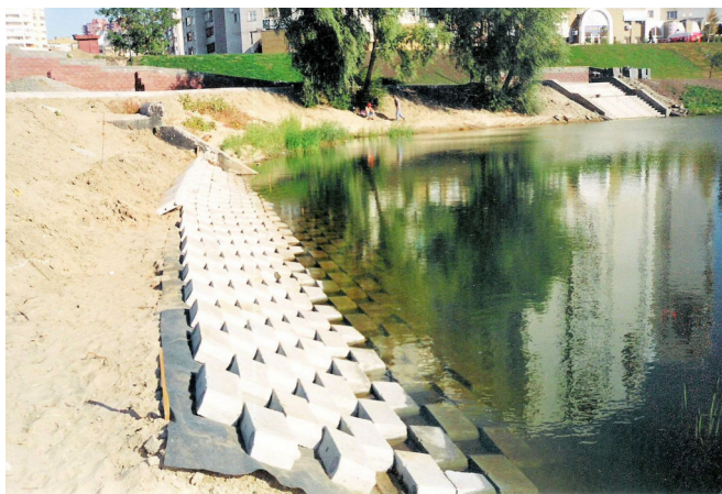
Захист укосів озера Позняки в м. Києві гнучкими кріпленнями з використанням нетканих геотекстильних матеріалів
