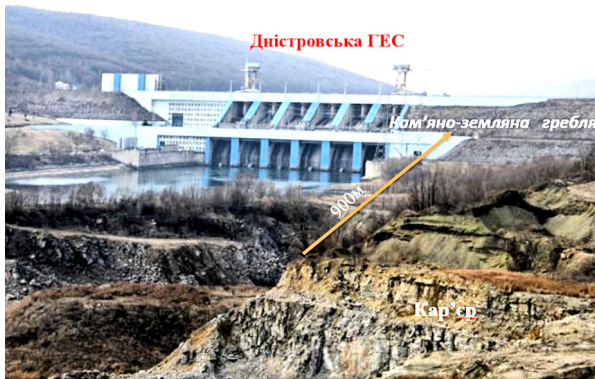
Дністровська ГЕС-1, кам'яно-земляна гребля та кар'єр в акваторії відстою суден
