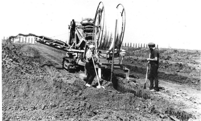
Укладання дренажу з волокнистими фільтрами
