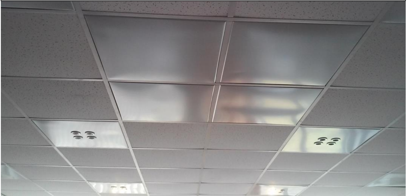
Квадратні плівкові нагрівачі, змонтовані на підвісній стелі
