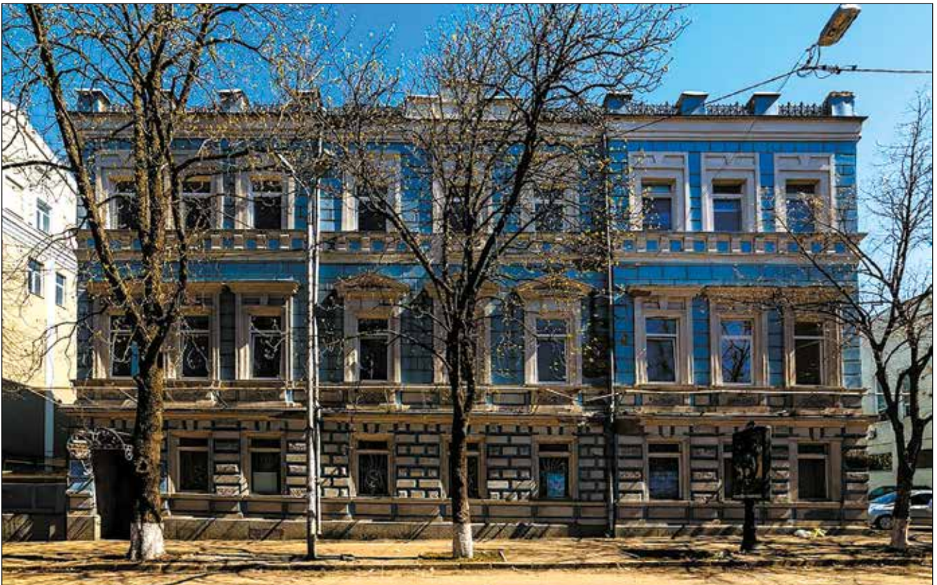
Рис. 8. Будинок по вул. Ярославів Вал, 36, де проходили перші Установчі збори УАН
